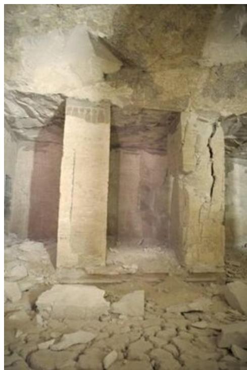
*Des zones inondées par le passé montrent des fissures sur le sol boueux, des ruptures de pilier et des affaissements de plafond*
